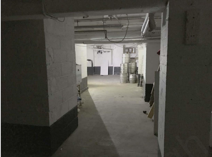
23. Cellar. Facing SE
