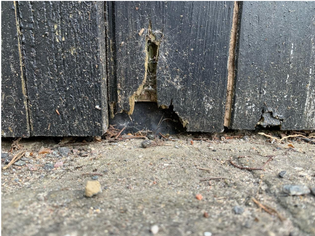
Rotting external false door
