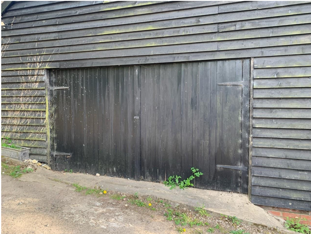
Rotting external false door
