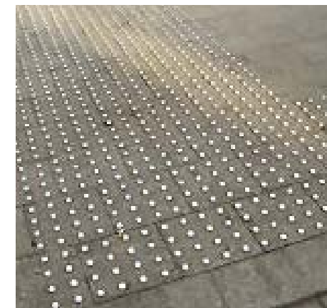
Metal stud demarcation
