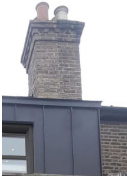
Fig. 010 zinc clad dormer
