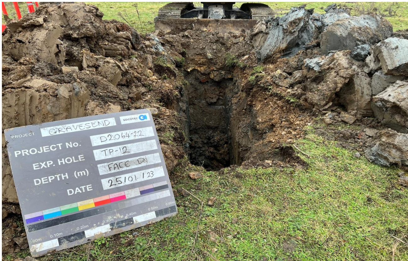
TP-12 Face D & Spoil
