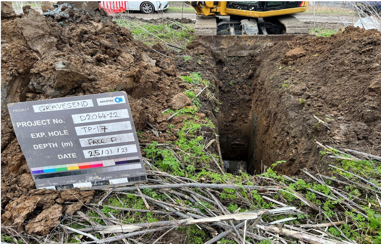
TP-17 Face D & Spoil
