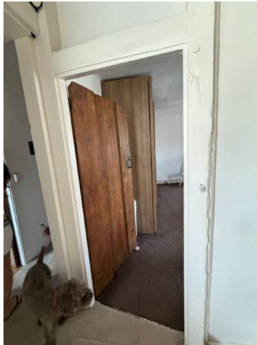
Fig 21– Original stud wall
