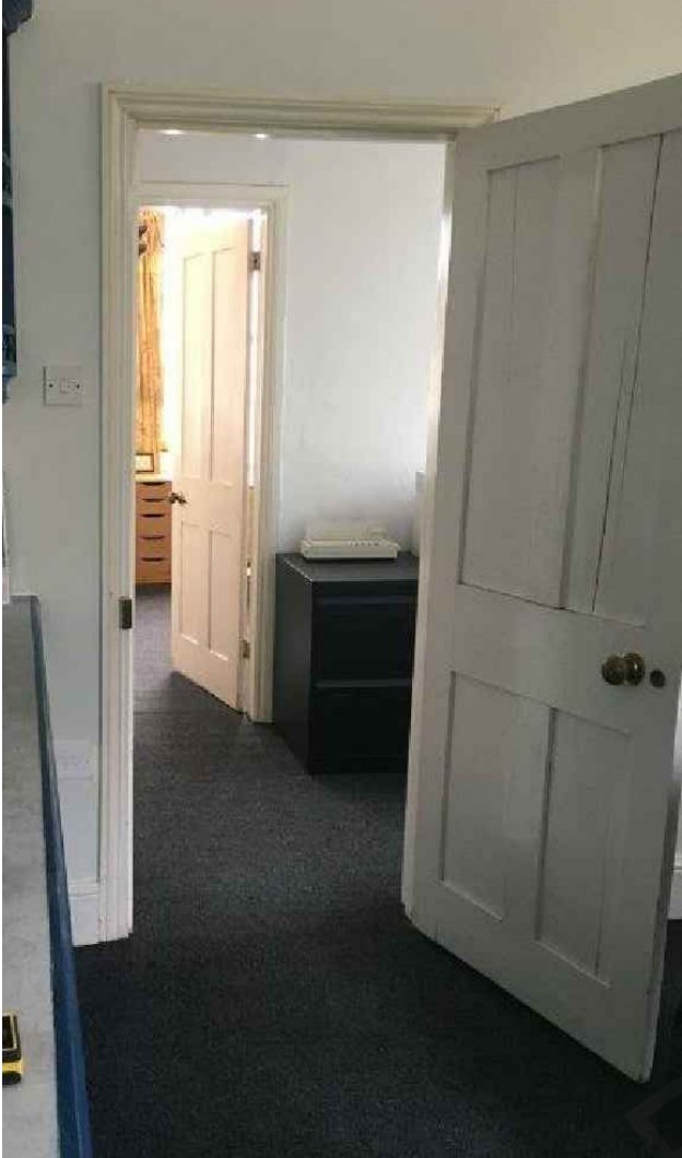
Existing Door D02
