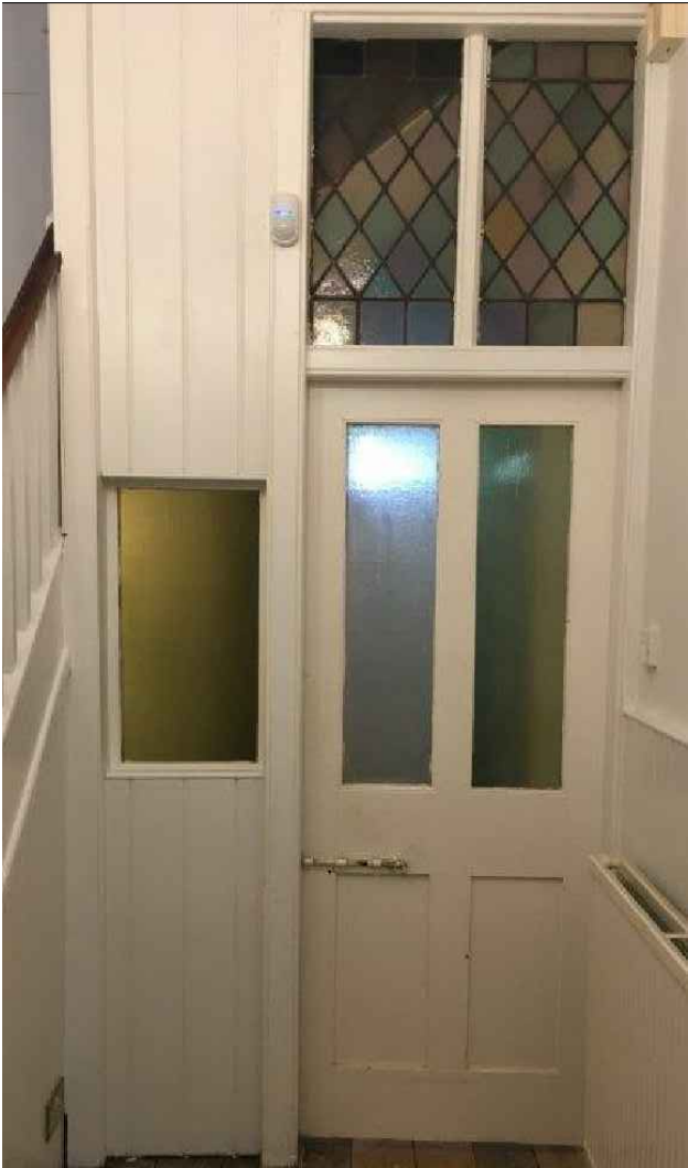
Existing Door D01
